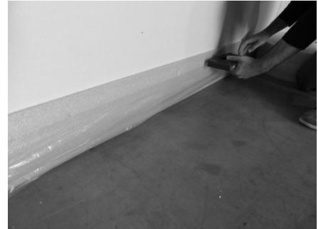
2. Mit der Verlegung des MiniTechnik-Noppenelementnetzes wird in einer Raumecke begonnen. Die Platten sind wandbündig und vollflächig zu verlegen. Hierzu wird die Schutzfolie von der Rückseite der Platte entfernt.
