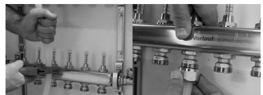
5. Vom Heizkreisverteiler weg beginnt nun die Fixierung des Heizrohres 12x1,3 mm.
