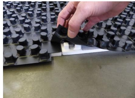
4. Die Folienlasche des Randdämmstreifens muss mittels Noppendichtstreifen in die Noppenplatte gedrückt werden. (Estrichdichte Fläche)
