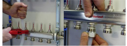
6. Vom Heizkreisverteiler weg beginnt nun die Fixierung des Heizrohres. Durch die Anordnung der Noppen ist eine axiale oder diagonale Verlegung des Heizrohres möglich. Das Heizrohr wird einfach per Fuß in die Noppenplatten gedrückt. Der Biegeradius  $5 \times D$  (  $5 \times$  Rohrdurchmesser ) darf nicht unterschritten werden. Auf eine Drallfreie Verlegung ist unbedingt zu achten.
