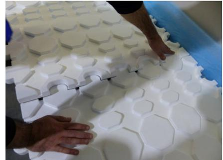
3. Im Anschluss werden die Wärmeleitbleche in die vorhandenen Führungsnuten eingelegt. Im Bereich der Umlenkung wird kein Blech verlegt. Die Sollbruchstellen (alle 12,5 cm) im Wärmeleitblech garantieren eine gute Anpassung.
