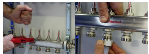
5. Vom Heizkreisverteiler weg beginnt nun die Fixierung des Heizrohres (max.  $D = 14 \text{ mm}$ ) - ideal: Metallverbundrohr. Das Heizrohr wird einfach per Fuß in die Wärmeleitbleche gedrückt und fixiert. Die Verlegung (mäanderförmig) erfolgt mit den erforderlichen Abständen zur Deckung des Wärmebedarfes. Auf eine Drallfreie Verlegung ist unbedingt zu achten.
