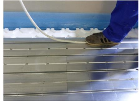
6. Zum Abschluss wird eine PE-Abdecktoleranzfolie 0,2 mm zur Abdeckung und als Trennschicht verlegt. Im Anschluss kann der Estrich (Trocken- oder Nassestrich) eingebracht werden.
