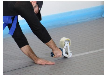
4. Die Folienlasche des Randdämmstreifens muss auf den Dämmrollen / Faltplatten angeklebt werden. (Estrichdichte Dämmschichtfläche)
