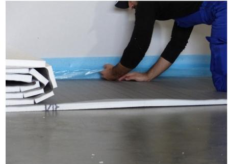
3. Der einseitige 3mm Folienüberstand der Dämmrollen / Faltplatten muss mit Spezial-Klebeband dicht abgeklebt werden. Ebenso müssen Stoßkanten ohne Folienüberstand an den Stoßfugen verklebt werden. (Estrichdichte Dämmschichtfläche)
