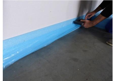
2. Mit der Verlegung der Dämmrolle / Faltplatte wird in einer Raumecke begonnen. Die Dämmung ist wandbündig und vollflächig zu verlegen. Der einseitige 3mm Folienüberstand ist längsseitig jeweils auf bereits verlegte Dämmrollen / Faltplatten aufzulegen.
